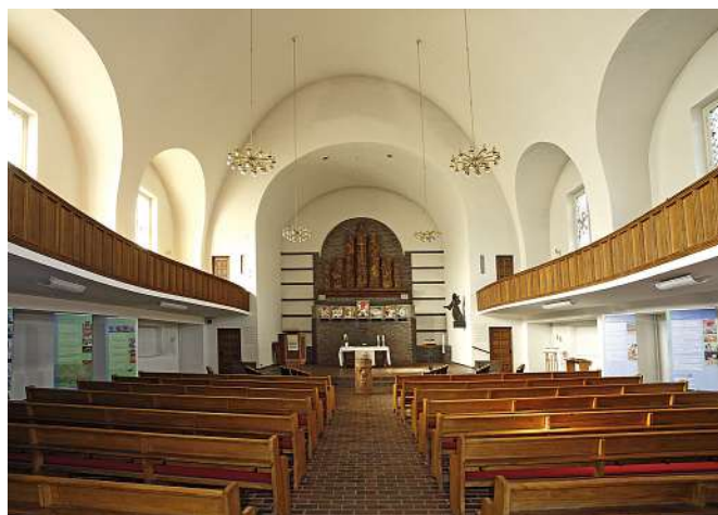
Bild 2: Die Anscharkirche in Neumünster: Vor der Leuchtenanierung bestand die Beleuchtung überwiegend aus unter der Decke angebrachten Kronleuchtern
